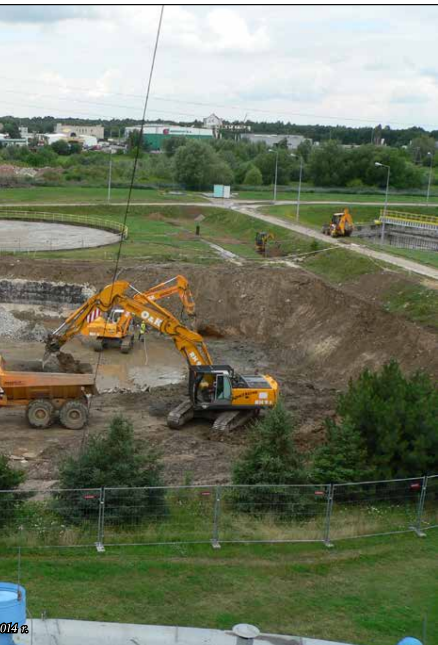
Oczyszczalnia Ścieków - modernizacja komór biologicznych osadu czynnego, 2014 r.
