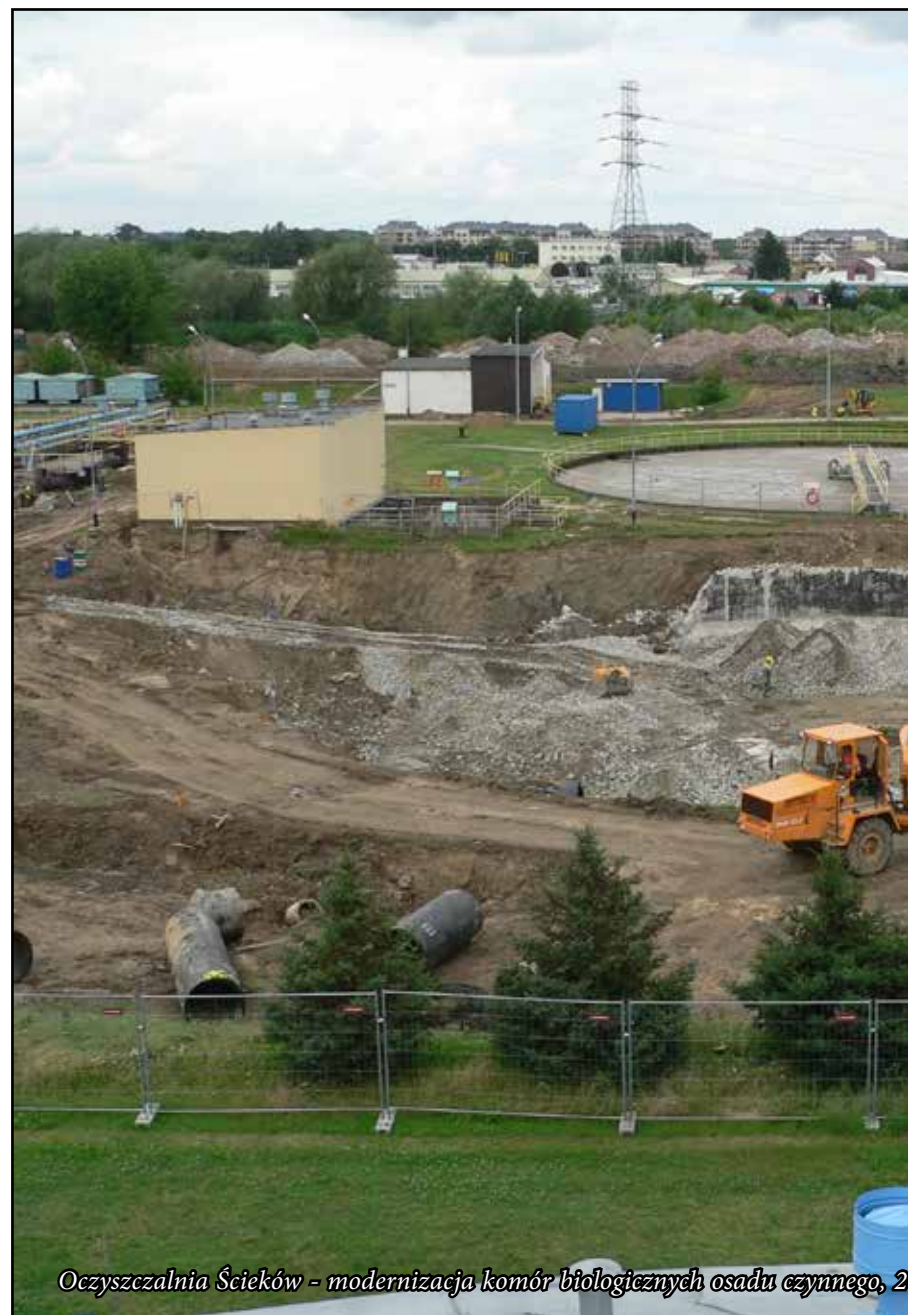
Oczyszczalnia Ścieków - modernizacja komór biologicznych osadu czynnego, 2013 r.
