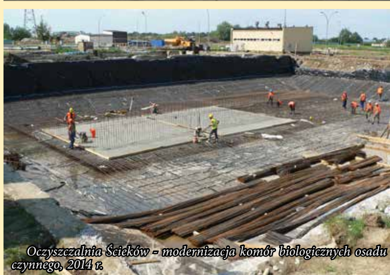
Oczyszczalnia Ścieków - modernizacja komór biologicznych osadu czynnego, 2014 r.
