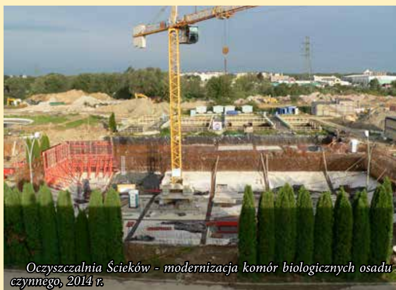
Oczyszczalnia Ścieków - modernizacja komór biologicznych osadu czynnego, 2014 r.
