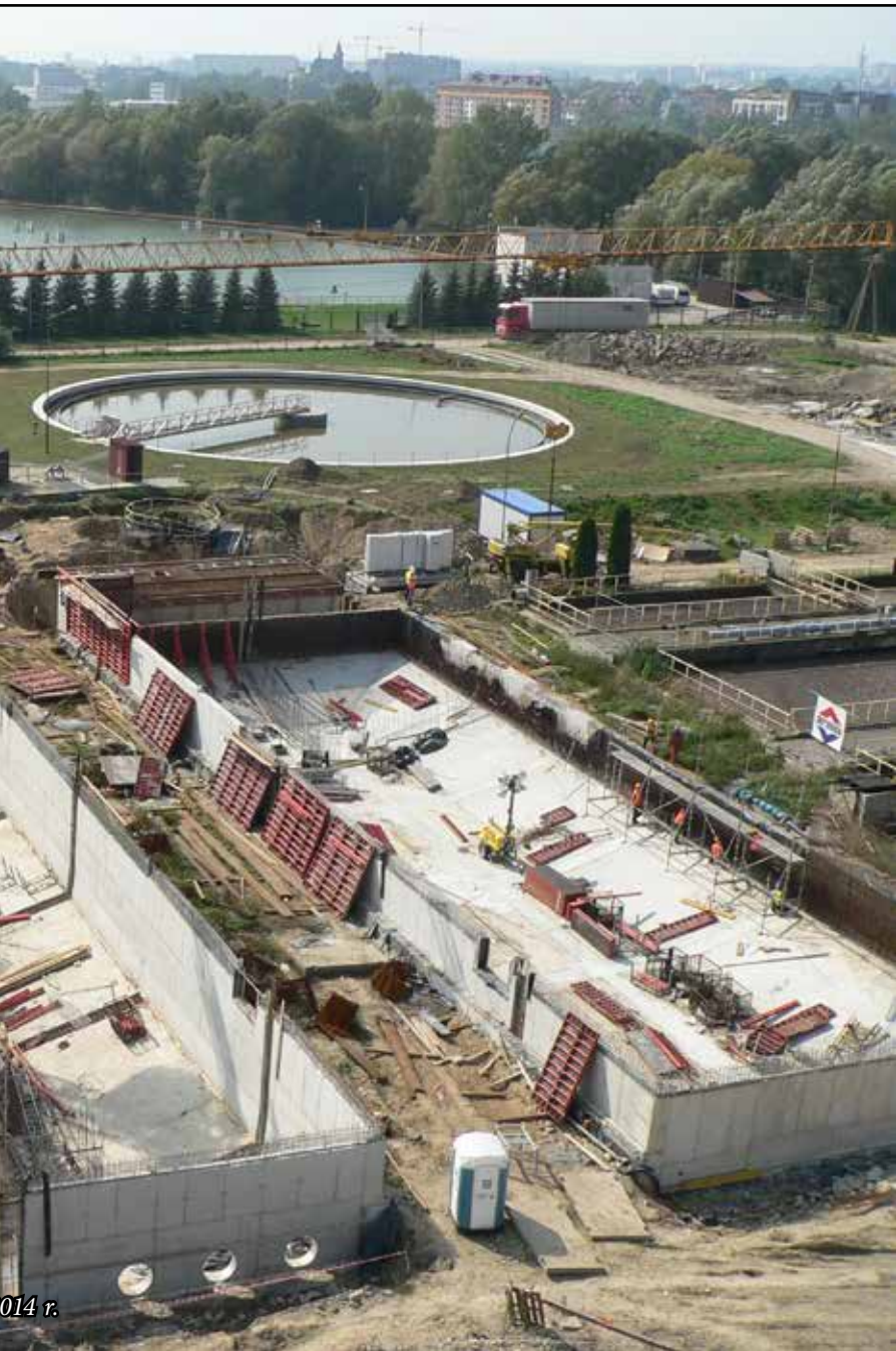
Oczyszczalnia Ścieków - modernizacja komór biologicznych osadu czynnego, 2014 r.
