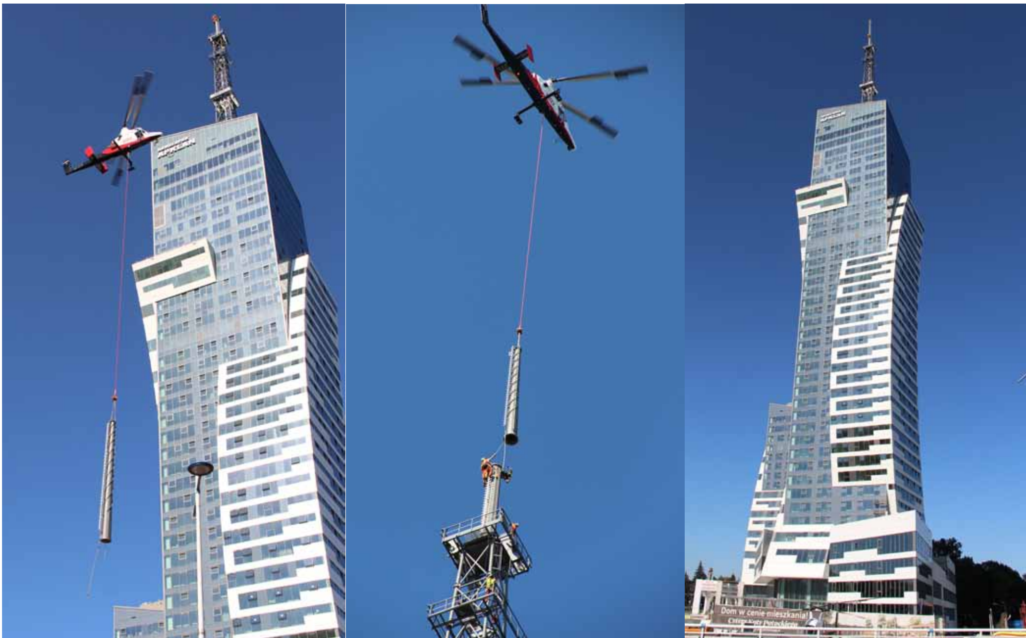
Montaż iglicy na najwyższym budynku w Rzeszowie. Fot. A Baranowski
